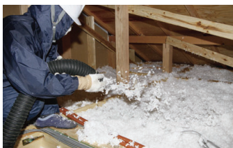
天井への施工
