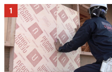
1 ネオマフォーム施工
