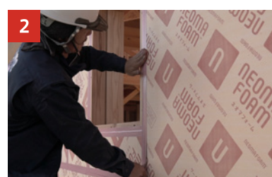
2 気密テープ張り
