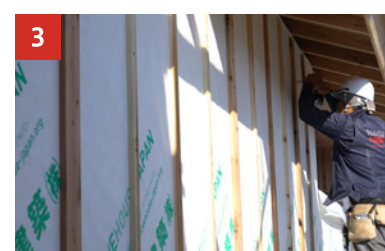
3 透湿防水シート張りと同縁の施工
